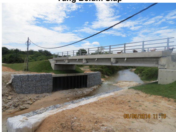
Gambar 3.7 Kerja Pembinaan Gabion Yang Belum Siap
