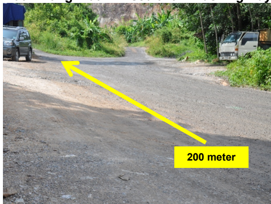
Gambar 1.10 Kuari Yang Tidak Disediakan Washing Bay
