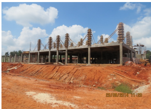
Gambar 2.1 Bangunan Bazar 2 Tingkat Yang Sedang Dalam Pembinaan
